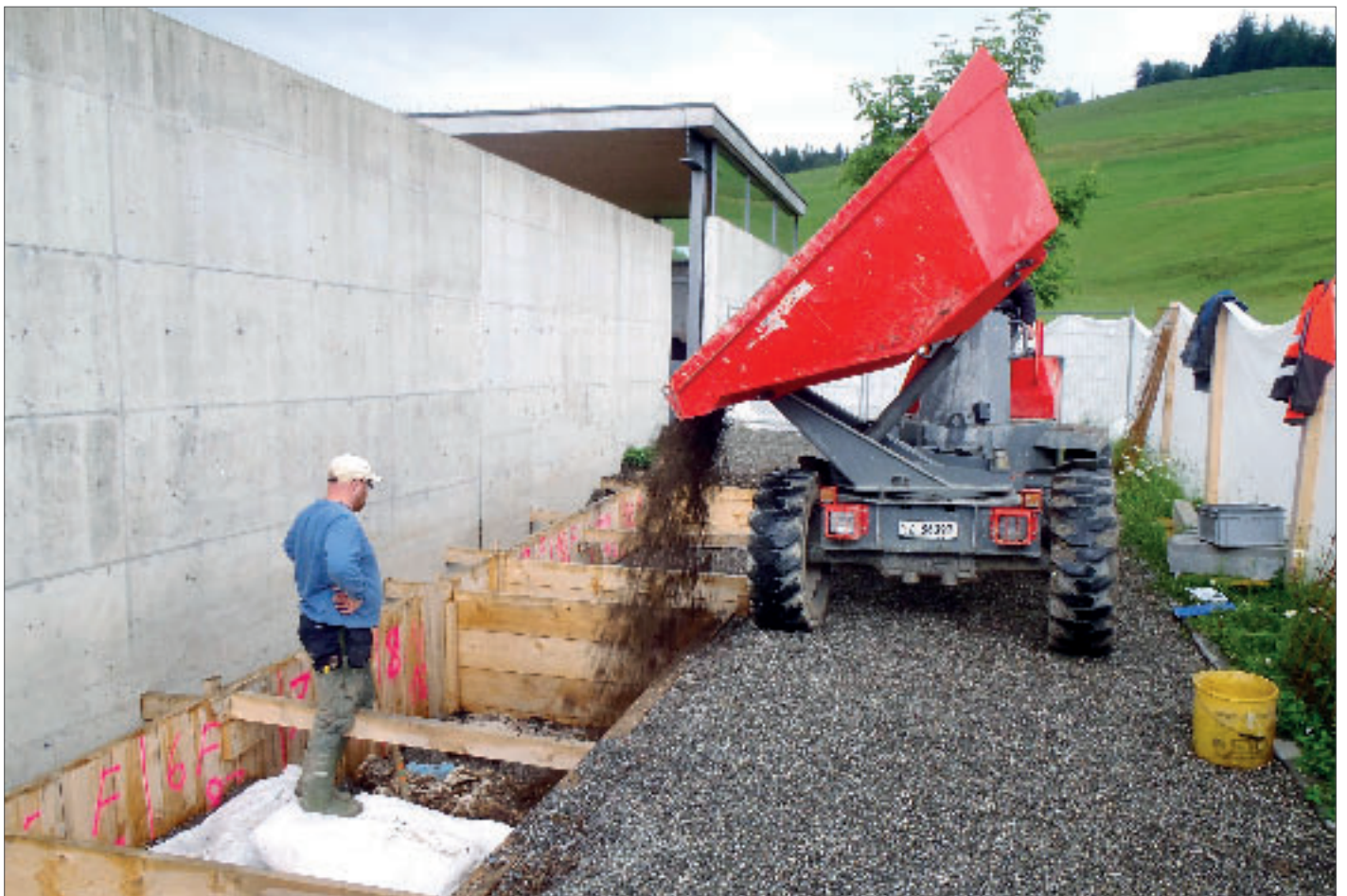
Verfüllen von Gräbern: das Testgrabfeld während der Wiederbestattung der ausgewählten Fettwachsleichen.
