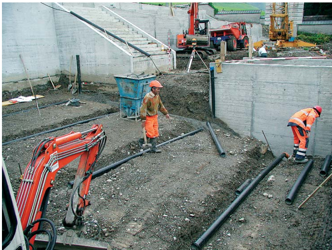
Einbau von Entwässerungsleitungen.
