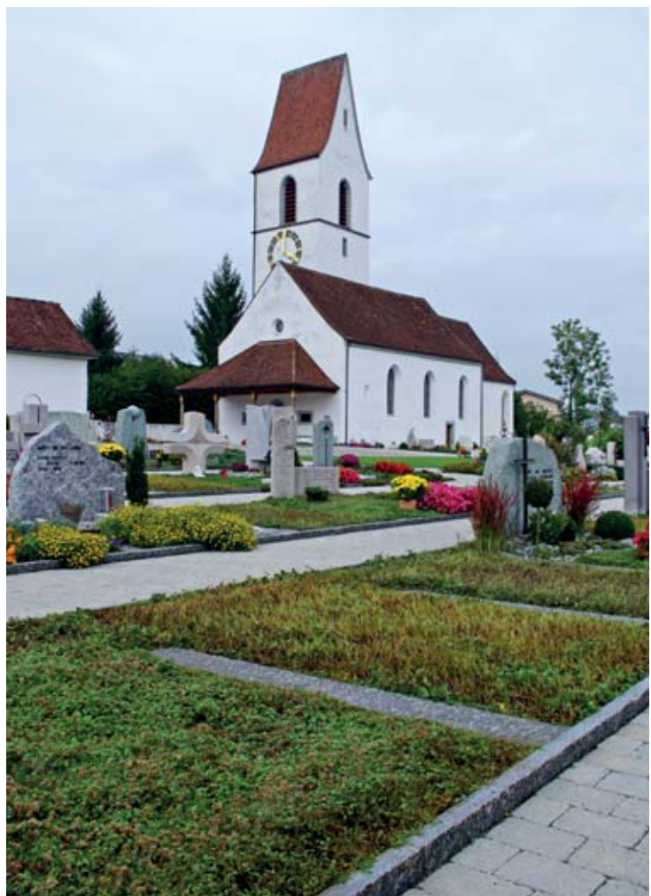
Noch unbelegt: Sanierte Grabfelder in Rothenburg LU.
