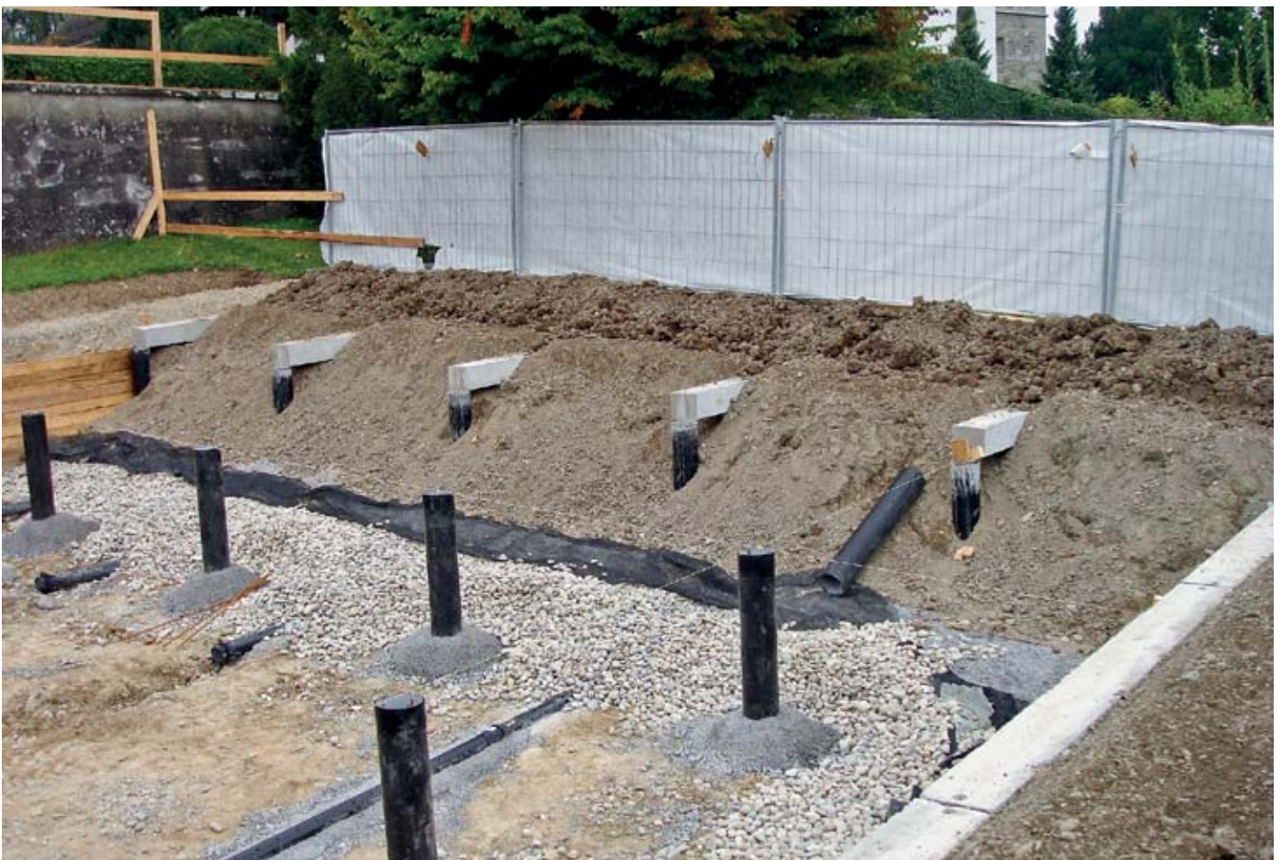
Grabfeldaufbau: Über die Entwässerungsröhre kommt eine Kiesschicht, die als Sickerfilter dient. Zudem werden Grabsteinfundamente gelegt. Bild: Alexandra von Ascheraden
