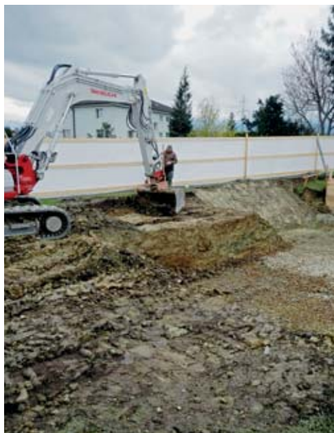
Respektvoller Umgang mit den sterblichen Überresten: Mit dem Bagger wird bei der Exhumierung nur bis zum Sargdeckel gegraben. Danach wird von Hand weitergearbeitet. Bilder: Erich Aeschlimann
