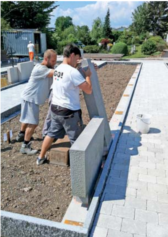
Kurz vor Abschluss einer Sanierung: Jetzt fehlen nur noch Grabsteine und Bepflanzung.
